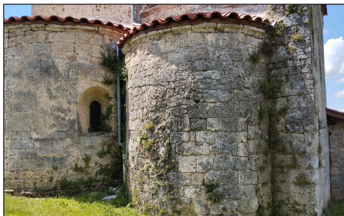
Abside et absidiole nord avec son appareil singulier, distinct du reste de l'église. Cl. A. L.
