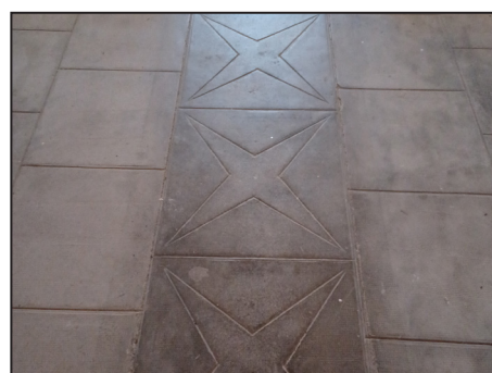
Sol en béton dans la nef, réalisé en 1909. CL. Th. B.
