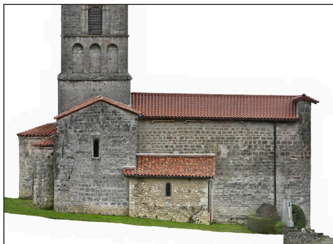
Vue du mur gouttereau méridional et ses trois différents appareils. Photogrammétrie Th. B.
