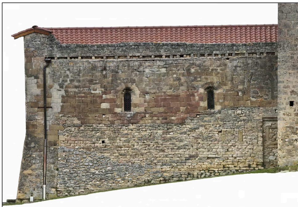
Vue du mur gouttereau méridional et ses trois différents appareils. Photogrammétrie Th. B.
