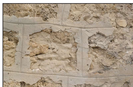
Couverture des joints au ciment. Cl. A. L.
