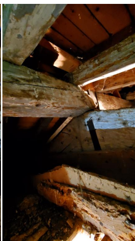
Sondages dans la voûte en plâtre pour accéder à la charpente
