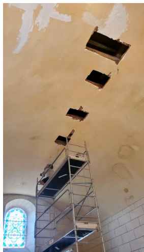
Sondages dans la voûte en plâtre pour accéder à la charpente
