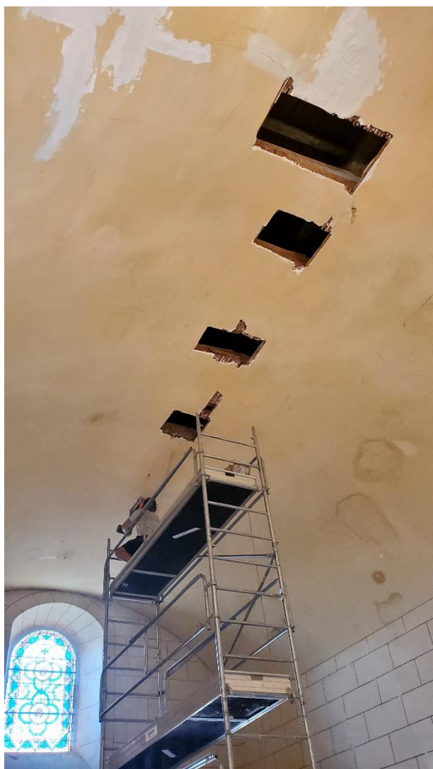
Figure 6 : Perçage du 5e sondage et vue des quatre autres. Le premier (le plus grand) se situant à l'extrême est de la nef (Cliché : F. Blondel).
