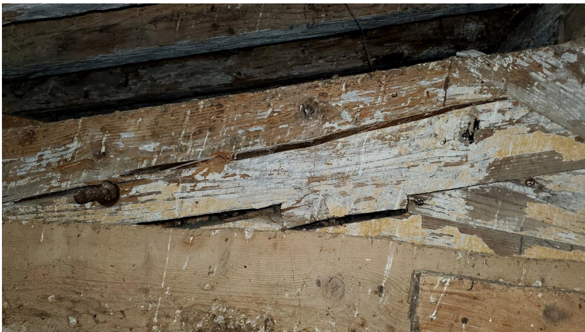
Figure 20 : Détail de l'assemblage d'une des fermes entre les deux arbalétriers à mi-bois, le faux-entrait partiellement caché par les planches de renfort et une planche fermant l'assemblage juste insérée dans une feuillure et maintenue par clouage (Cliché : F. Blondel).
