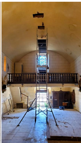
Sondages dans la voûte en plâtre pour accéder à la charpente
